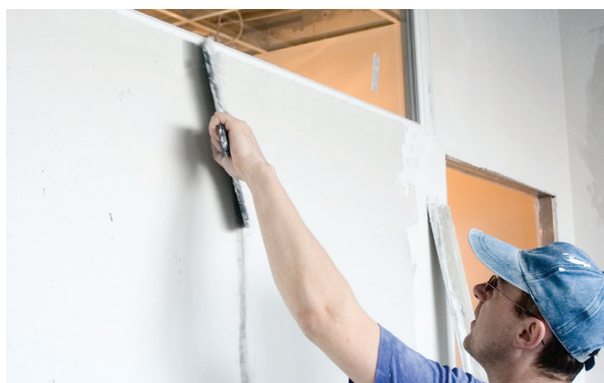
用填缝料处理隔墙。
