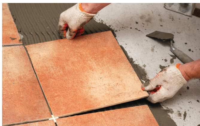
用瓷砖胶粘贴面砖在安装好的板面。
