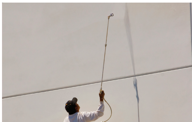
水基或油基涂料均适合喷涂在安装好的板面。
